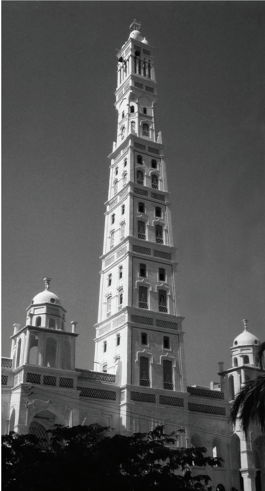
Torre de la mesquita de Tarim, Yemen. 38 m de altura, construido de adobes hechos a mano
