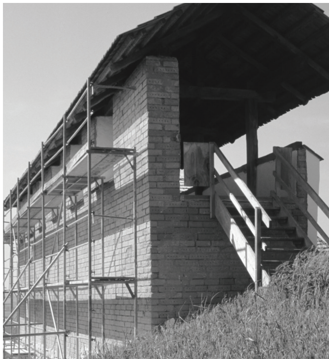
1.2-8 Reconstrucción de un muro de adobe del siglo VI a.C., Heuneburg, Alemania
